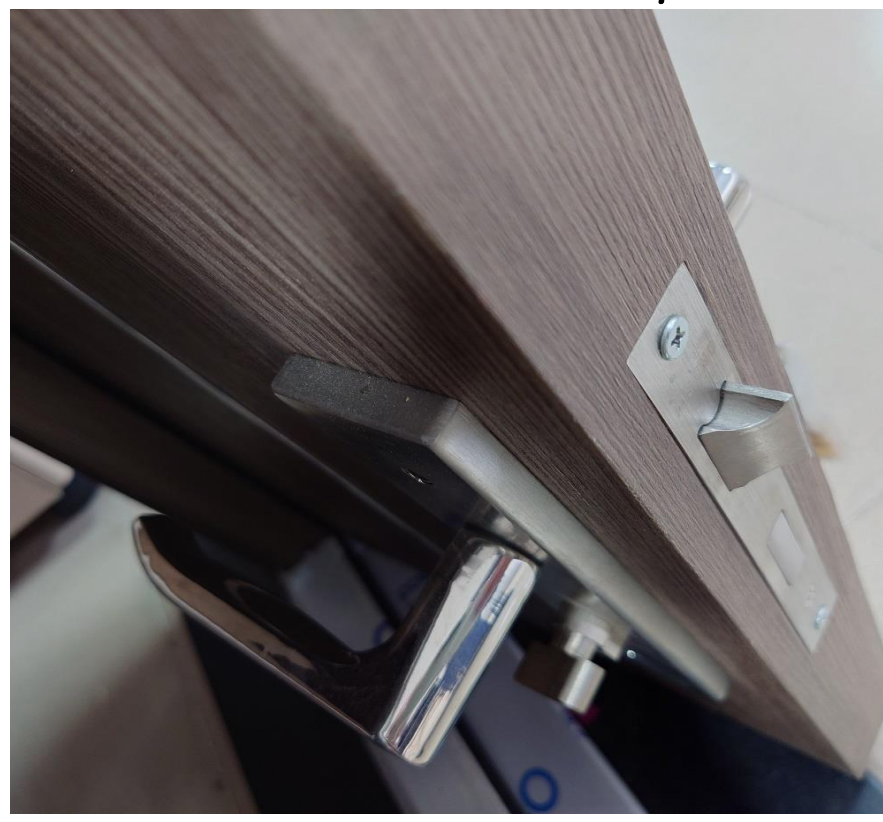
5. Cánh HGF Laminate hoàn thiện
