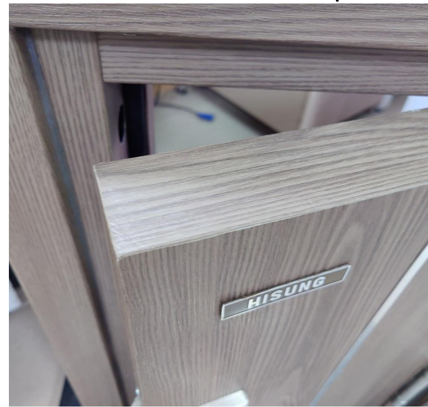
6. Cánh HGF Laminate hoàn thiện
